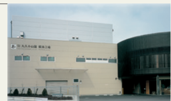
Fabrik und Showroom in Makishima
