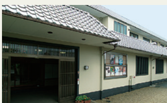
L'usine de notre siège
